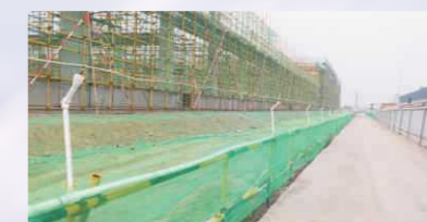
裸露地块覆盖防尘网、安全护栏降尘措施
