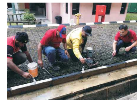
与当地施工人员一起施工
