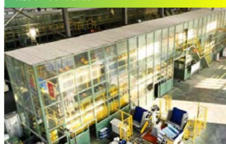
隔音、降噪机房
